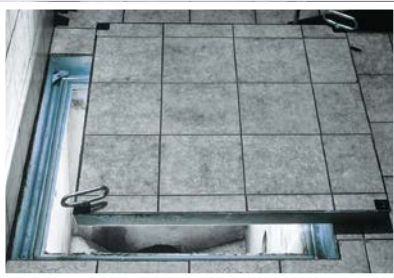
BV over a manhole
