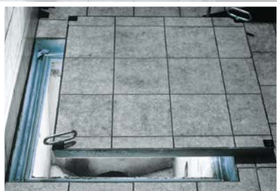
BV eingebaut in Putzschacht
